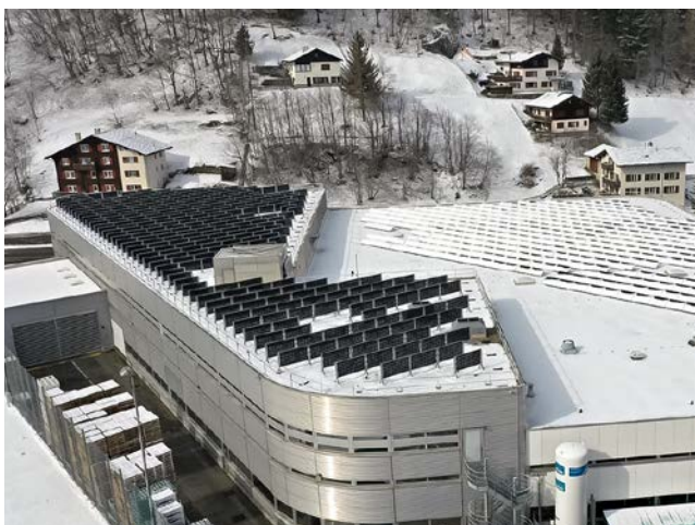
Auf dem Dach der Valser-Wasser-Produktion folgte die dritte Testanlage, erneut mit bifazialen Modulen. Vals, 2019.
