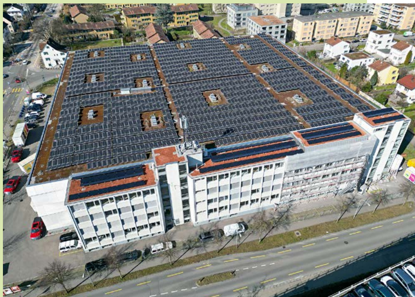
Der vordere Teil des Gebäudes (mit dem rötlichen Substrat) wurde 2024 neu mit einer Solaranlage versehen.
