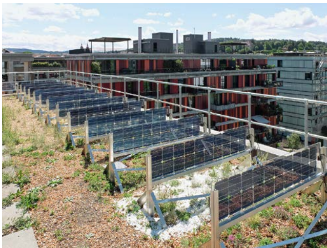
Bei der zweiten Testanlage stand die Biodiversität und die Wasserretention im Fokus. Seniorenheim Winterthur, 2015.
