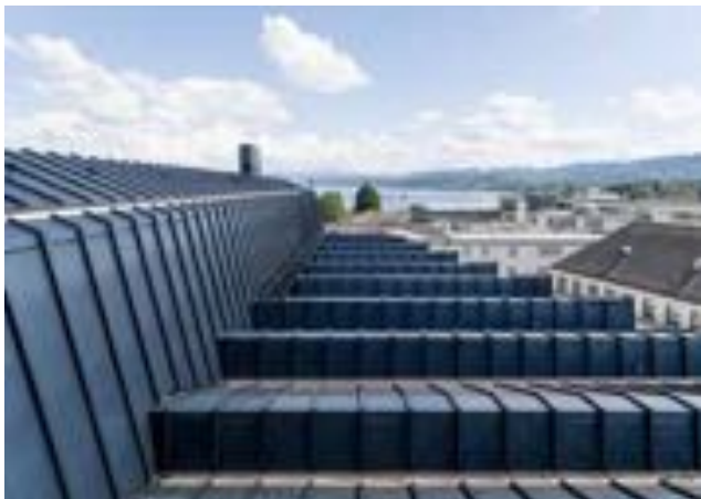
Das prägnante Sheddach zur Talstrasse hin blieb erhalten.
