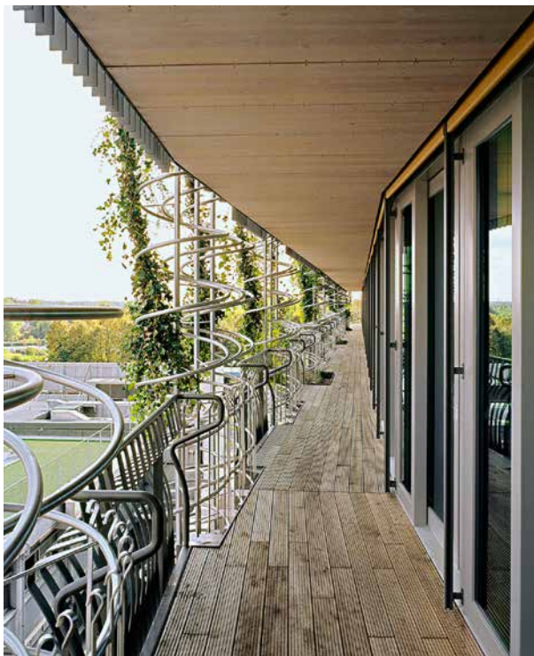
Von den Jahreszeiten gesteuert: Wechselgrüne Ranken beschatten die grossflächigen Fenster. Meili Peter Architekten, Centro Helvetia, Mailand, 2009
