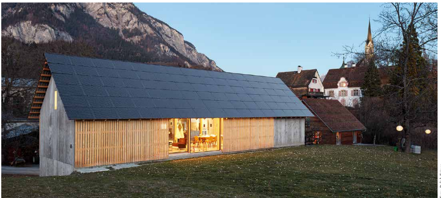
Gut ins architektonische Gesamtkonzept integriert ist ein Solardach auch in einer ländlichen Gegend kein Fremdkörper mehr. Bearth & Deplazes, Neubau Wohnhaus Schneller Bader, Tamins, 2017
